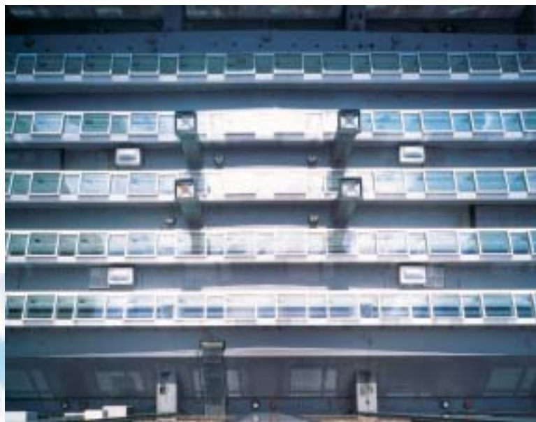
Крыша сберкассы после реконструкции. Шедовая конструкция, специально спроектированная производителем световых полос.
