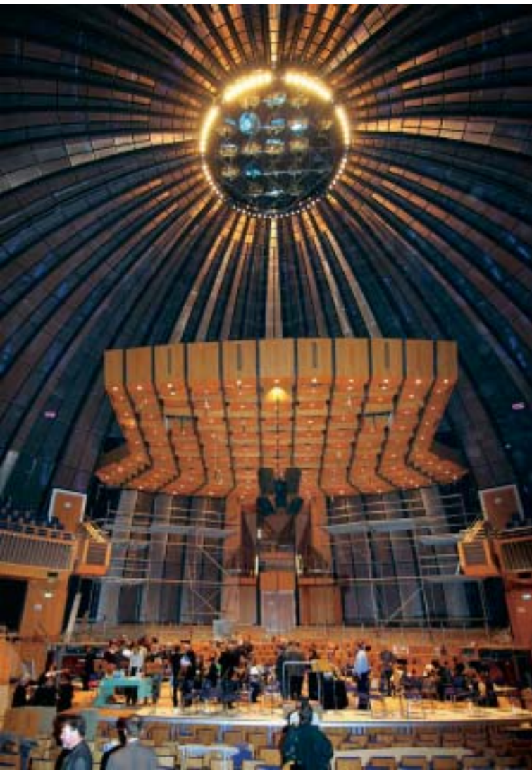
Отремонтированный зал в Дюссельдорфе: панели, сотканные из нержавеющей стали и бронзы в соответствии с критериям акустики. Фото: GKD / Бенедикт Йерусалем, Дюссельдорф
