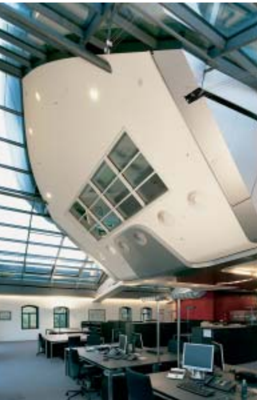
Края кормы корабля из предварительно изготовленных гипсовых “чаш”
